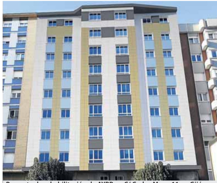
Proyecto de rehabilitación de AYRR en C/ Carlos Marx, 11 en Gijón.
