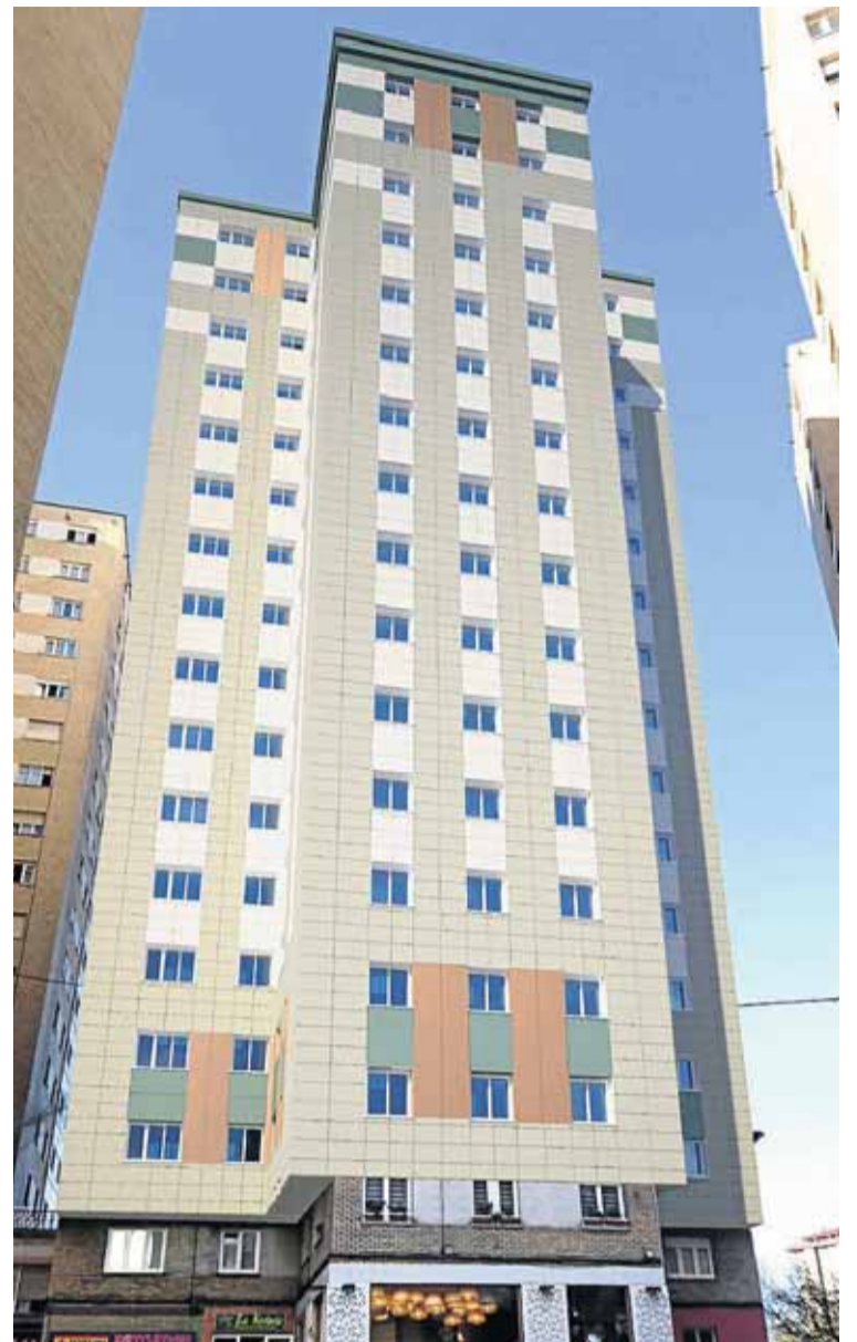
Proyecto de rehabilitación de AYRR en C/ Lastres 6 y 8 en Gijón.
