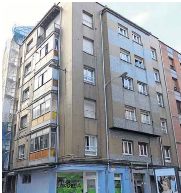
Proyecto de rehabilitación en curso C/ San José-Gijón.
